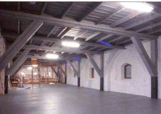
De nieuwe depotruimte op de derde verdieping. In de muren zijn de dichtgezette spitsboogvensters van de kerk te zien, ervoor de houtconstructie uit 1752 en de nieuwe vloer uit 2006. (Foto: Gerard de Graaf)
